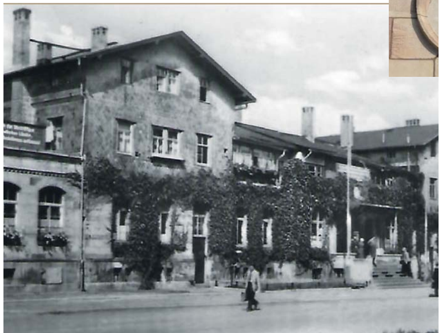
Bahnhofsansichten aus zwei Jahrhunderten – im Bild links aus den 1950er-Jahren, im Bild rechts aus den Gründerzeitjahren der Eisenbahn
